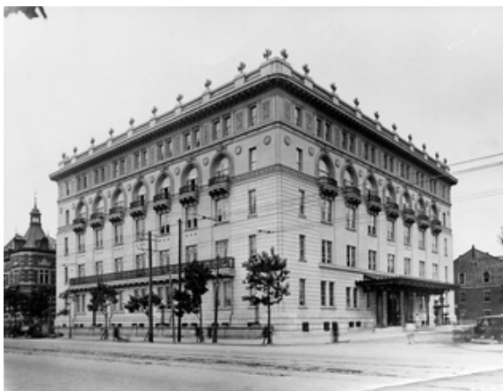
東京會館 旧本館
